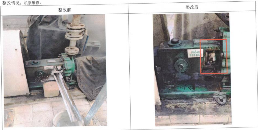
附件 1、环保 P004C 半干塔加压机封漏 整改情况：机泵维修。
